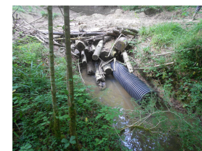
tube PEHD surmonté de billons de bois
