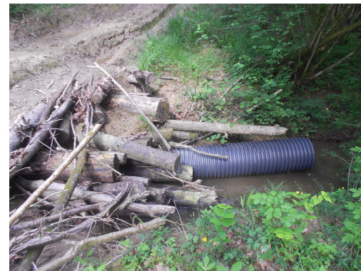
tube PEHD surmonté de billons de bois
